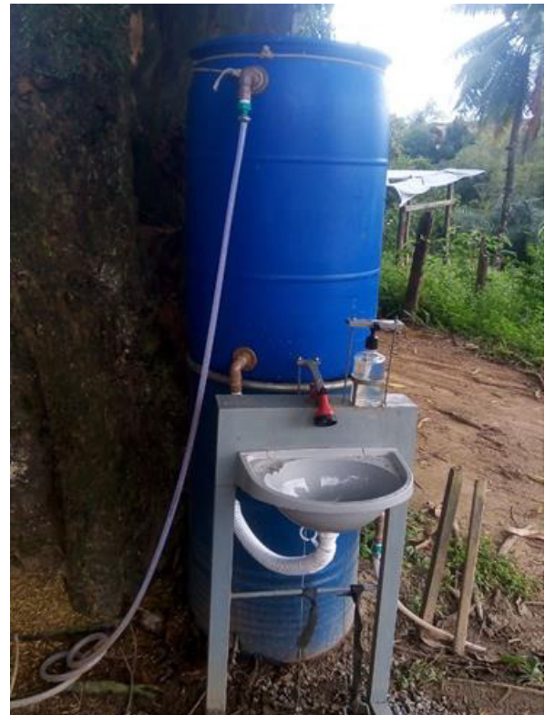
Instalação de pias - ocupações MSTB.
